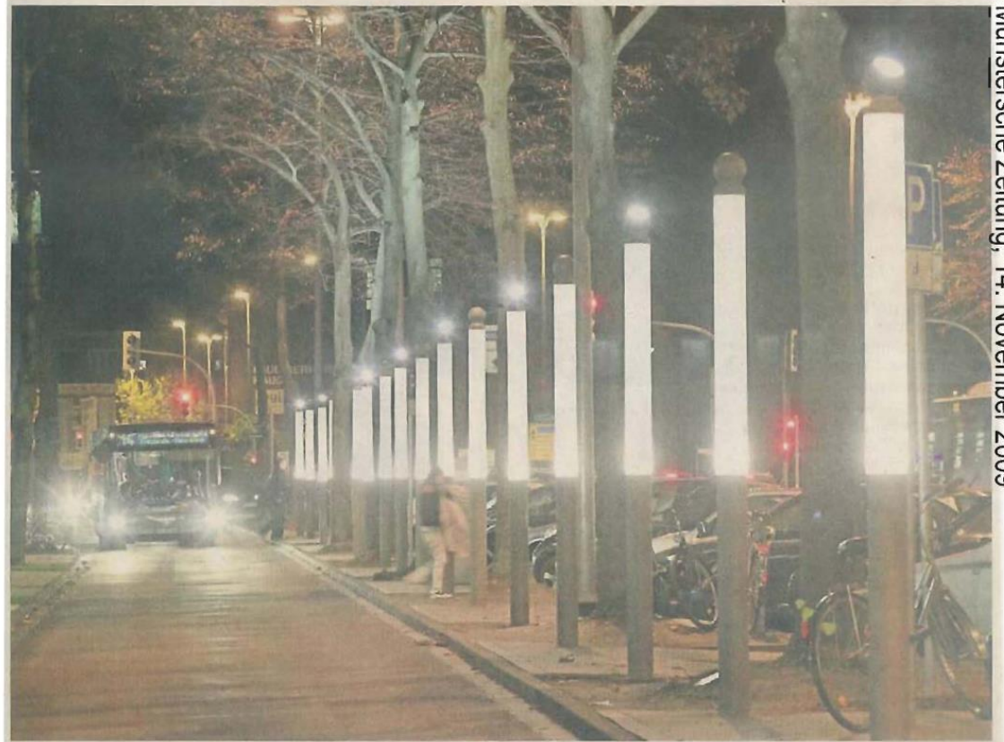
Mit Stelen und Strahlern wird seit gestern die Bahnhofstraße ins rechte Licht gesetzt.
